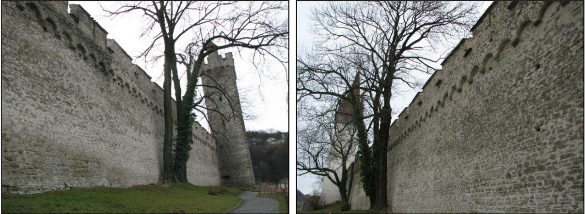
Abb. 1: Der fertig renovierte Abschnitt wirkt optisch sehr lebendig und unterscheidet sich auf den ersten Blick kaum vom noch unsanierten Teil. Fledermäuse nehmen die bewegte Oberfläche mit ihrem Ultraschall wahr und finden so die geeigneten Einschlüpfen (Fotos: Ruth Ehrenbold).
