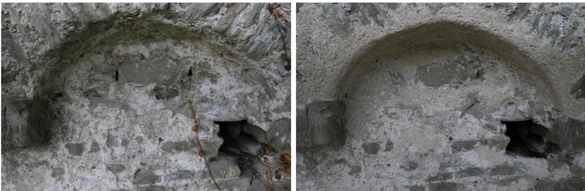
Abb. 8: Mauernische im Arkadenbereich vor und nach der Sanierung (Bilder: Sebastian Meyer)
