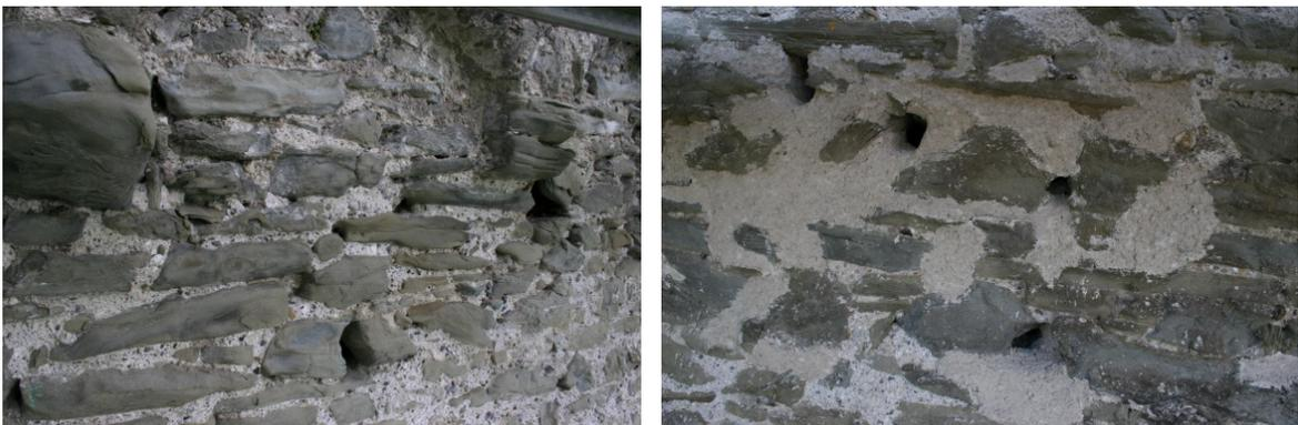
Abb. 7: Mauerabschnitt mit Mauersegler-Brutplätzen sowie weiteren kleineren Löchern für Fledermäuse, Eidechsen, Insekten und andere Kleintiere; vor (links) und nach (rechts) der Sanierung (Bilder: Sebastian Meyer)
