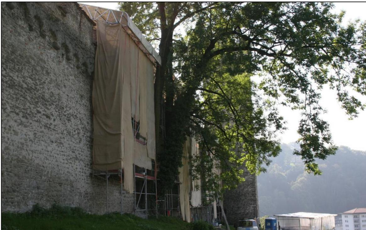
**Abb. 6: Museggmauer und Männliturm (im Hintergrund) mit dem um die dreistämmige Esche herum montierten Gerüst. (Foto: Sebastian Meyer)**
