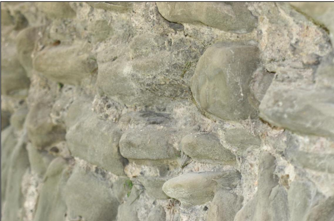
Abb. 5: Typische Verwitterungssituation im Bereich der Mauer-Nordseite ohne Brutplätze. Der Verputz blieb zwischen den stark verwitterten Sandsteinen erhalten, ohne dass geeignete Löcher für Kleintiere entstanden sind (Bild: Sebastian Meyer).
